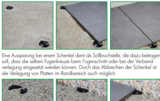
Eine Aussparung bei einem Schenkel dient als Sollbruchstelle, die dazu beitragen soll, dass die selben Fugenkreuze beim Fugenschnitt oder bei der Verbandverlegung eingesetzt werden können. Durch das Abbrechen der Schenkel ist die Verlegung von Platten im Randbereich auch möglich.
